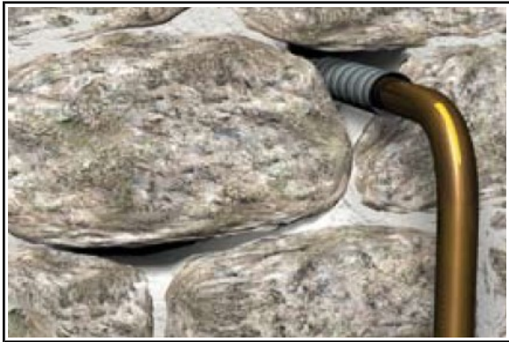
Situation initiale avant colmatage
