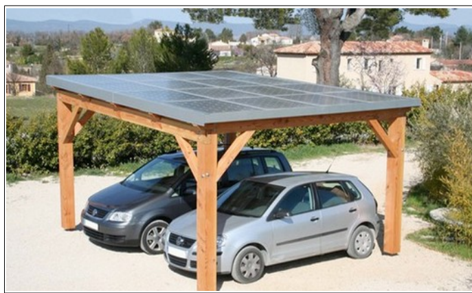
Construction annexe non contiguë
