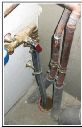
Exemple d'entrées de réseaux à calfeutrer
