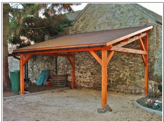
Construction annexe adossée à façade
