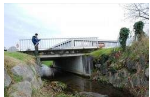
FIG. 23 : Ouvrage de franchissement Boulevard des Pyrénées
