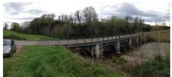
Pont sur la RD 24
