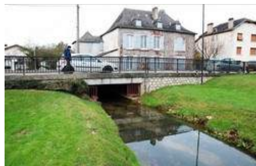
FIG. 22 : Ouvrage de franchissement Rue Tristan DEREME
