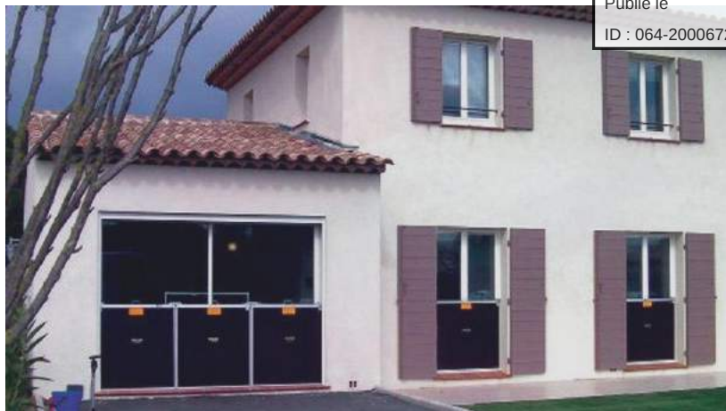
Exemple de protections des ouvertures
