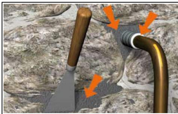
Situation après travaux de colmatage
