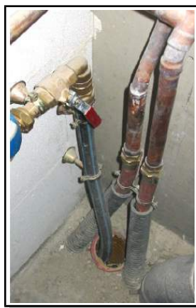
Exemple d'entrées de réseaux à calfeutrer
