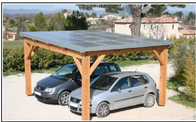
Construction annexe non contiguë
