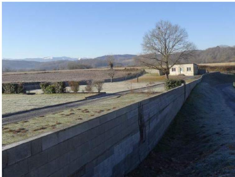
**Fig. 56. Exemple de mur créant un obstacle aux écoulements**
