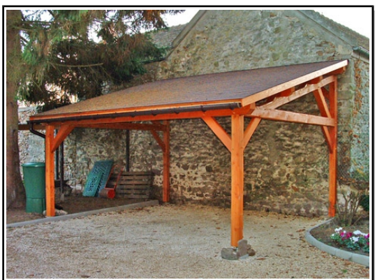
Construction annexe adossée à façade
