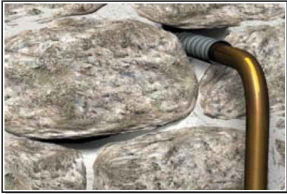
Situation initiale avant colmatage
