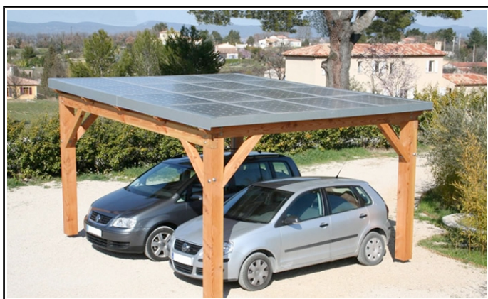
Construction annexe non contiguë
