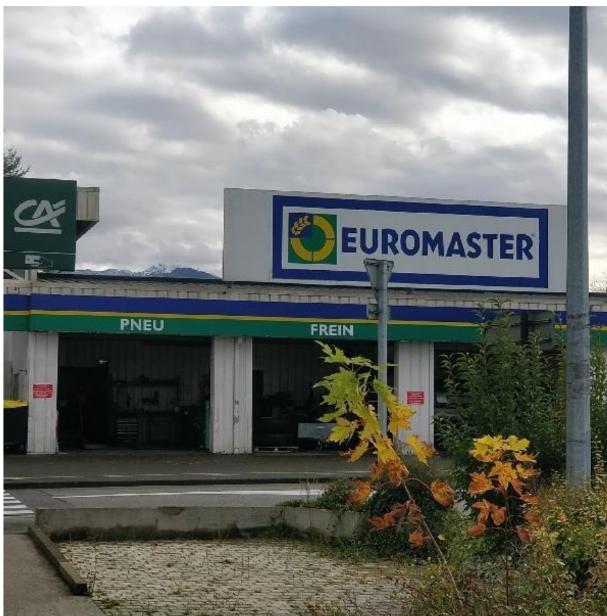
Une enseigne en toiture interdite.
