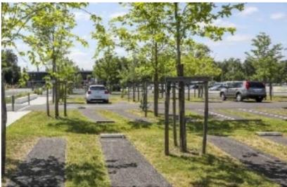
Les parkings sont souvent imperméables pour faciliter la circulation des véhicules et piétons en évitant, par exemple, l'enlèvement des jours de pluie. Par voie de conséquence, l'eau ruisselle jusqu'aux canalisations, emportant la pollution des sols avec elle et sans s'infiltrer dans le sol.
