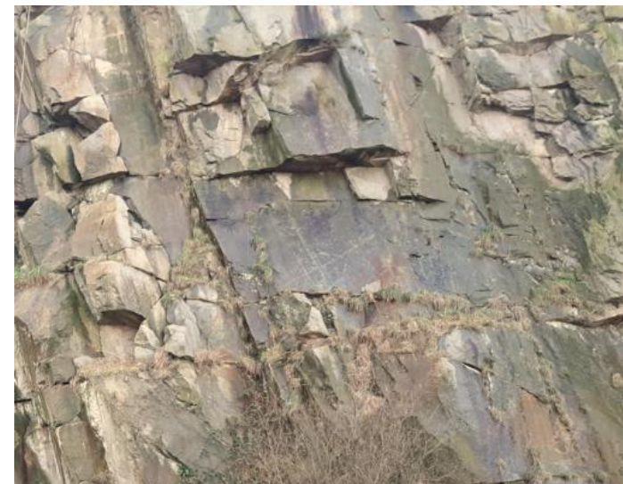
Vue du front Sud (ENCEM)
