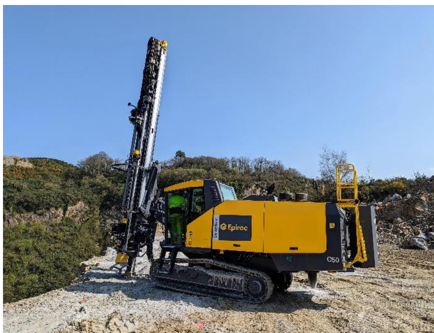
Figure 11 : Foreuse du groupe Lagadec
