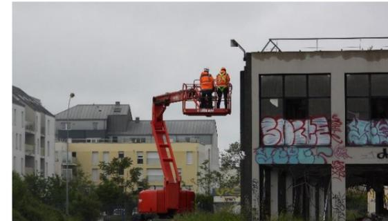
**Photo. 13 : contrôle des anfractuosités extérieures sur le bureau Br.1 avec nacelle (O-GEO, 21/05/2024)**
