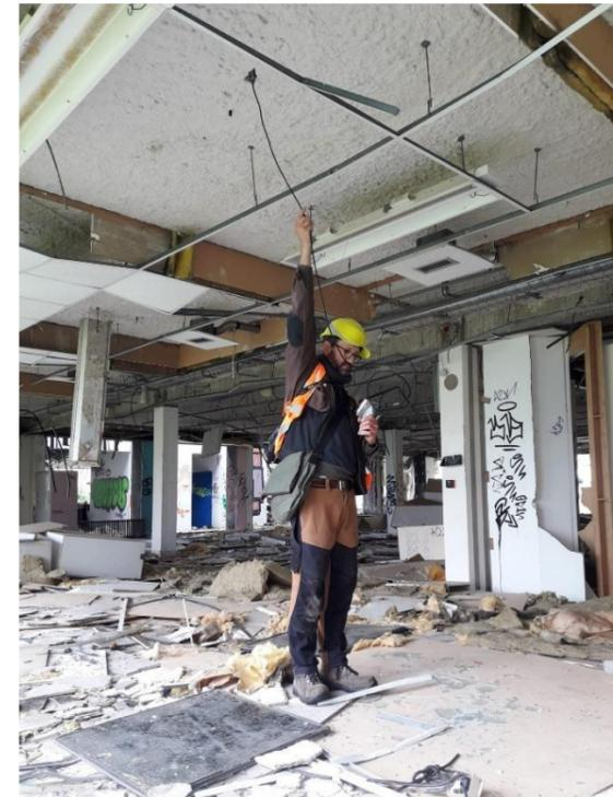
**Photo. 15 : contrôle d'une cavité dans le plafond du bureau Br.1 à l'aide d'un endoscope (O-GEO, 21/05/2024)**
