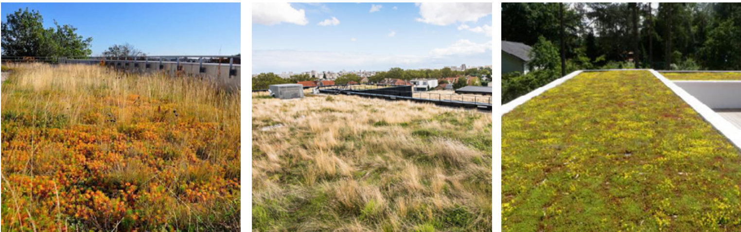
Des toitures végétalisée extensives sur les parties les plus hautes - 15cm de substrat
