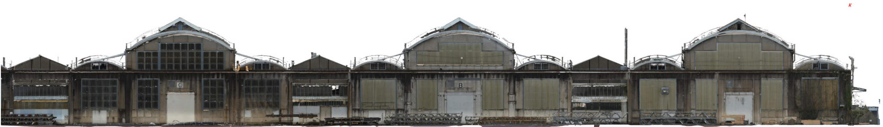
Vue d'ensemble des pignons Nord-Ouest des 3 nefs
