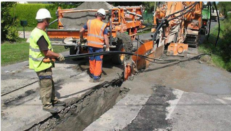
Figure 44 : Illustration d'un passage de câbles électriques sous voirie (Source : La Voix du Nord, Ouest France)
