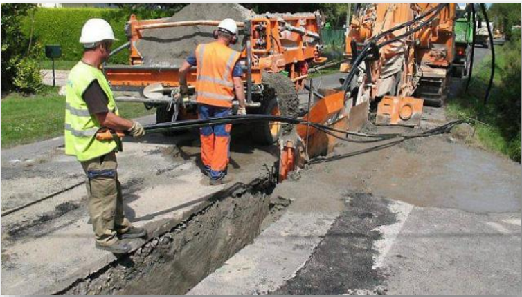
Figure 169 : Illustration d'un passage de câbles électriques sous voirie (Source : La Voix du Nord, Ouest France)
