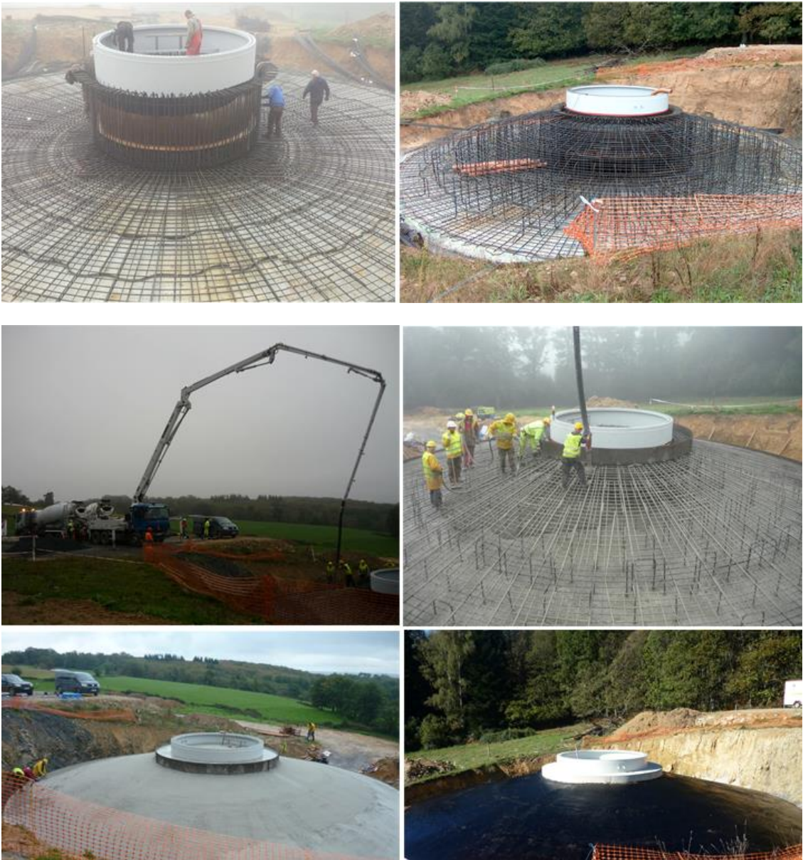
Figure 149 : Les étapes de construction d'une fondation pour une éolienne (Source : VESTAS)
