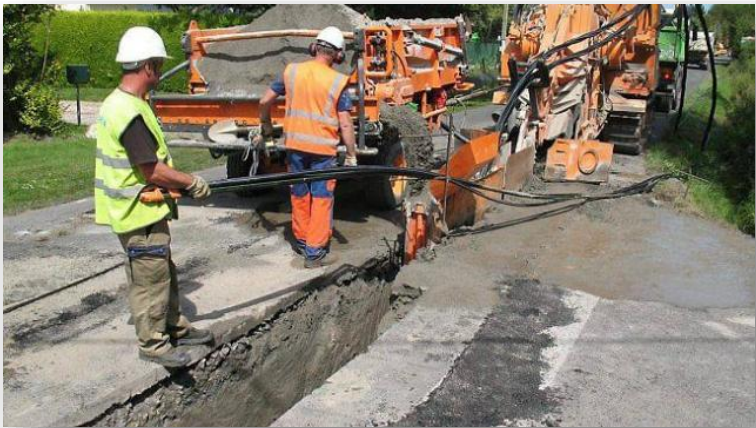
Figure 36 : Illustration d'un passage de câbles électriques sous voirie (Source : La Voix du Nord, Ouest France)
