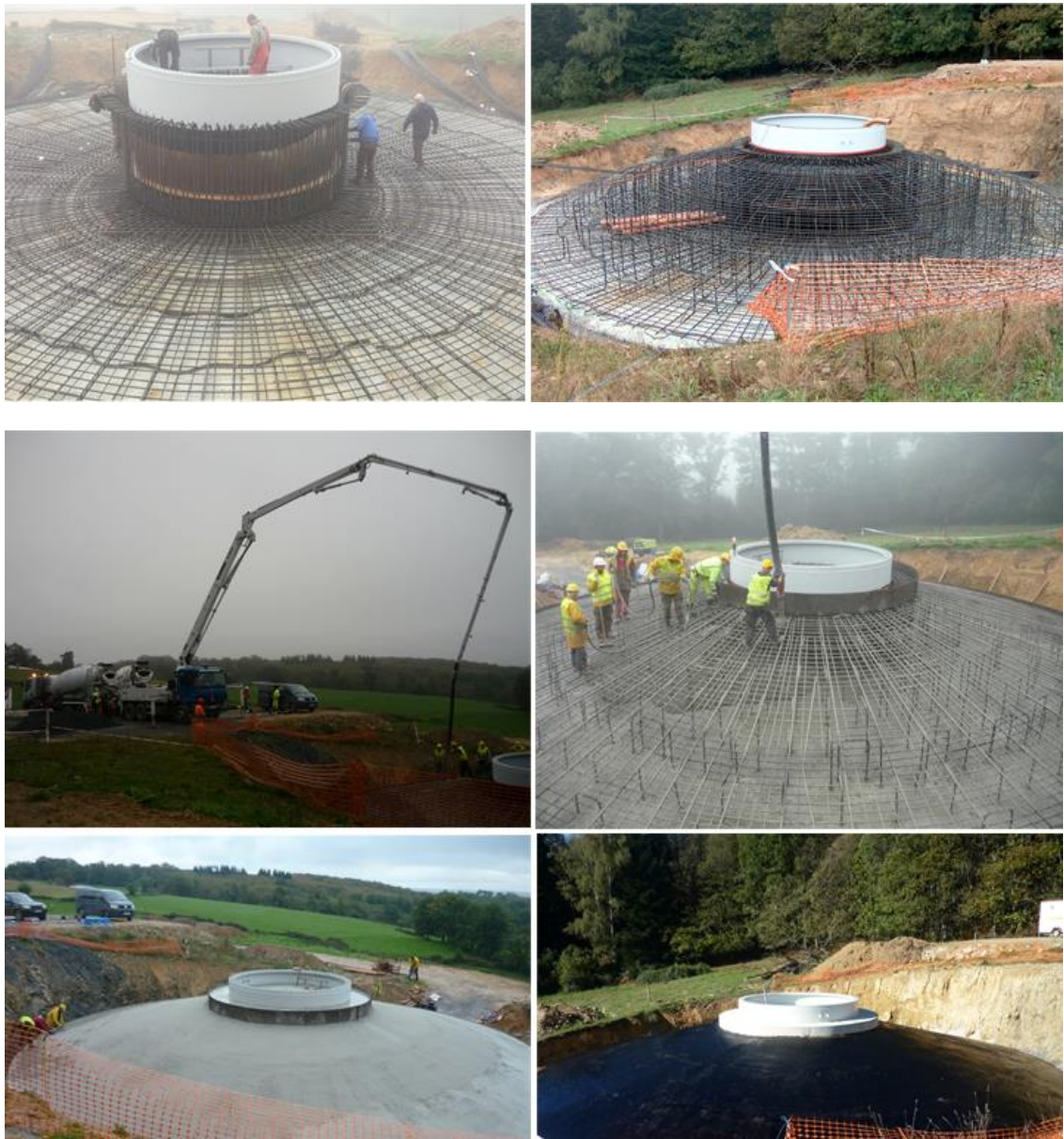
Figure 16 : Les étapes de construction d'une fondation pour une éolienne (Source : VESTAS)
