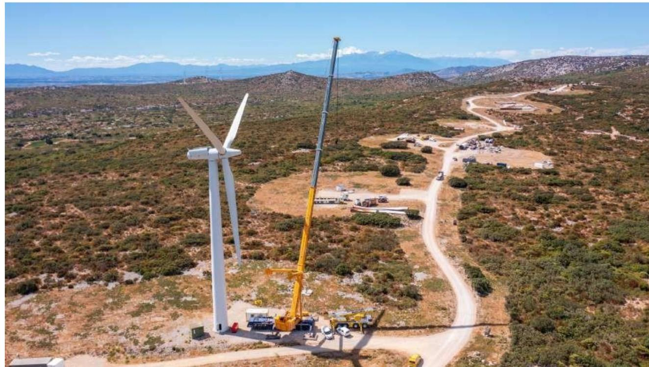
Figure 12 : Démantèlement d'un parc éolien (source : Q ENERGY France)
