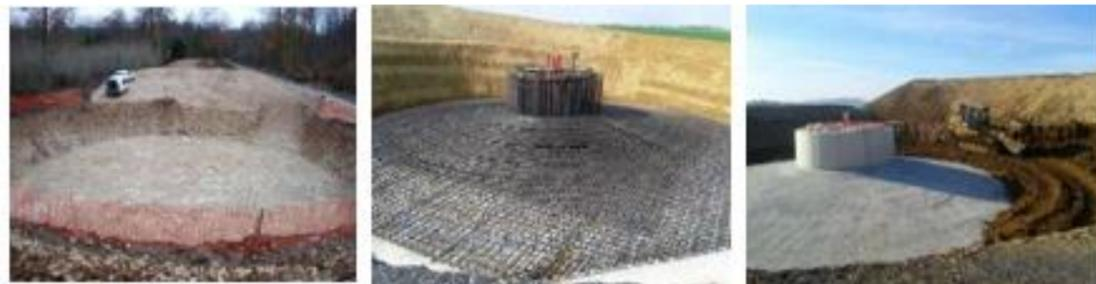
Figure 10 : réalisation des fondations, phase d'excavation, phase de ferrailage, phase de remblaiement (source : Q ENERGY France)
