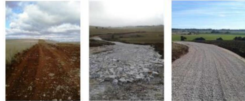
Figure 8 : Opération de décapage, mise en place de la couche de fond, mise en place de la couche de finition
