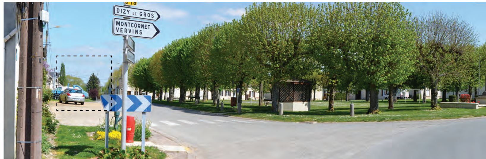
Vue panoramique depuis le centre-bourg de Lappion - zoom sur des éoliennes visibles
