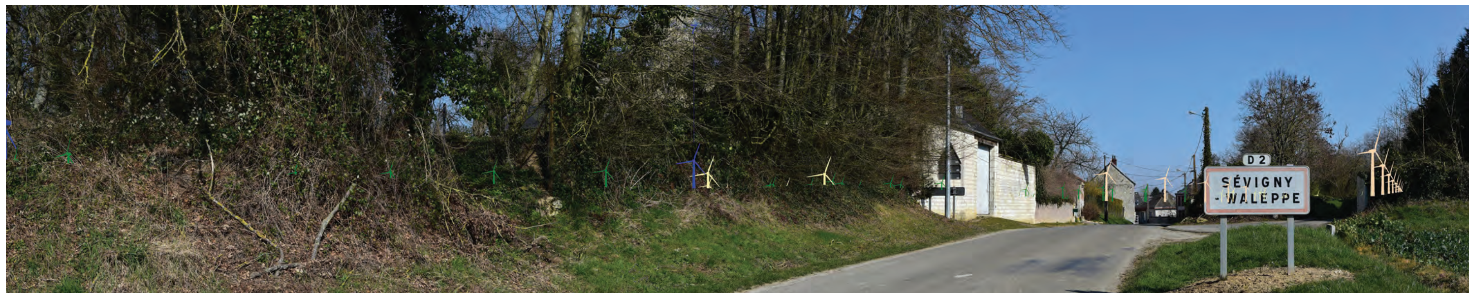
Vue panoramique 6 - photomontage esquissé depuis l'entrée sud-ouest de Sévigny-Waleppe sur la D2
