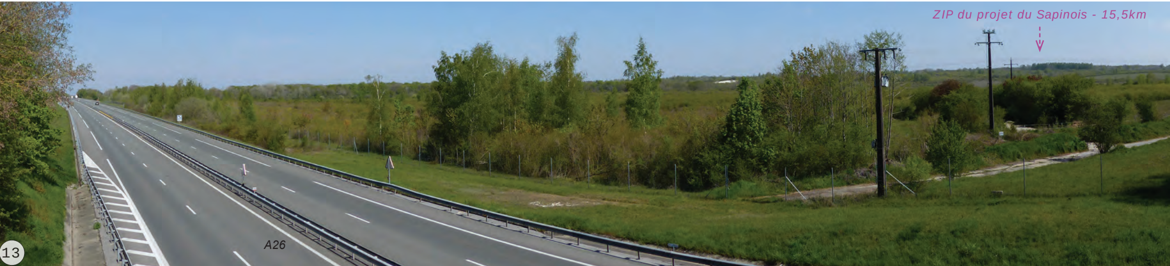
13 Vue panoramique depuis l'A26 à la hauteur de Saint-Erme-outre-et-Ramecourt, dans l'unité paysagère du Laonnois
