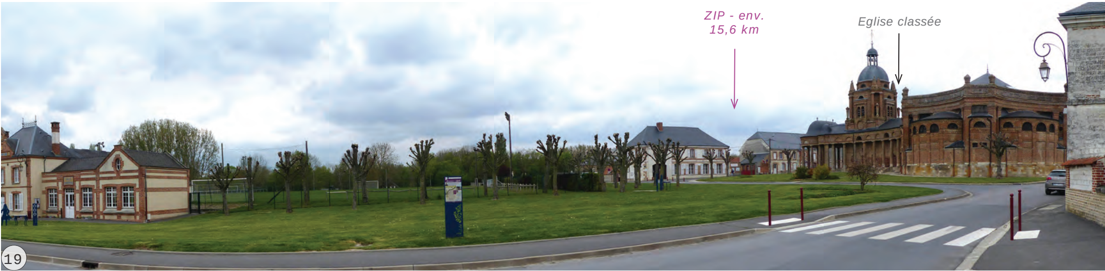
Vue panoramique sur l'église d'Asfeld, classée
