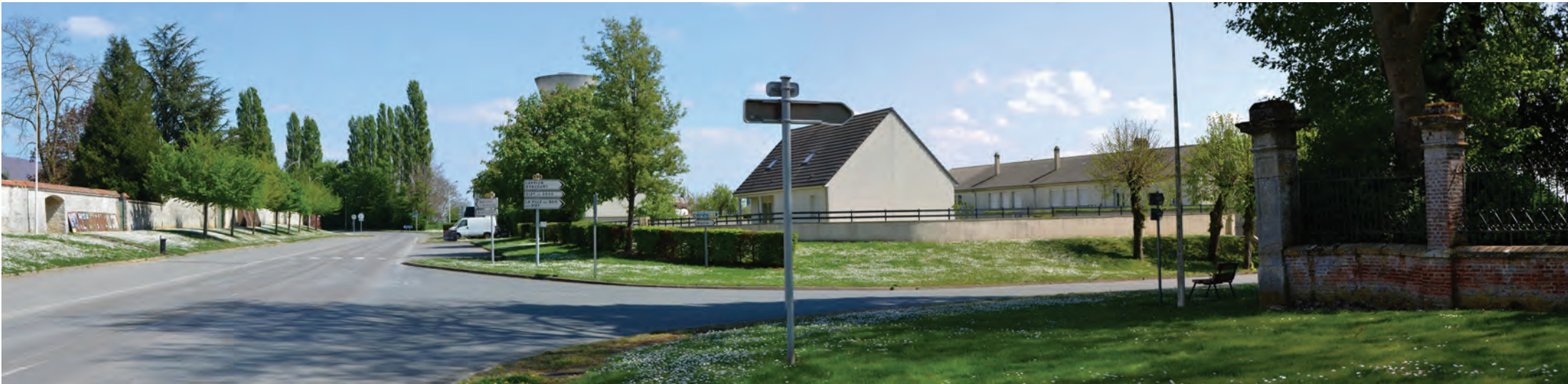
➡ Vue panoramique depuis le centre de Clermont-les-Fermes
