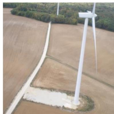
Figure 19 : Exemple d'aire de grutage d'une éolienne en milieu cultivé (source : QENERGY, 2022)
