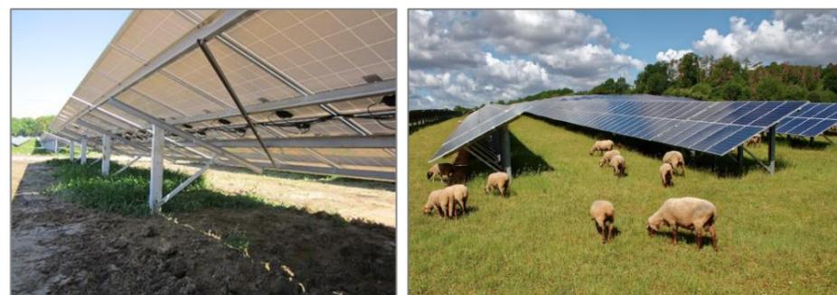
Photographie 9 : Structures porteuses des tables photovoltaïques (Source : ENCIS Environnement, Impulsion)
