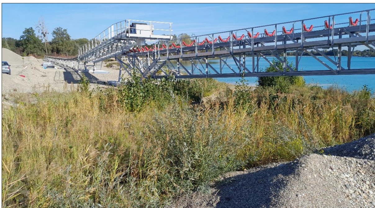
Figure 26 : Zone de décantation des eaux de process avant rejet dans le plan d'eau (ENCEM)
