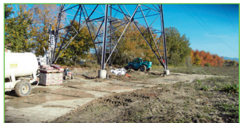
Exemple de plaques de protection des sols
