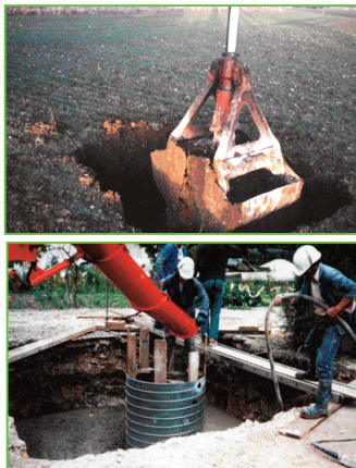
Réalisation de fondations : creusement, mise en place et bétonnage d'un massif de fondation, recouvrement
