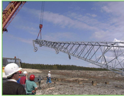
Assemblage au sol et levage d'un pylône
