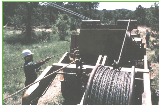
Déroulage de câbles à l'aide d'un treuil
