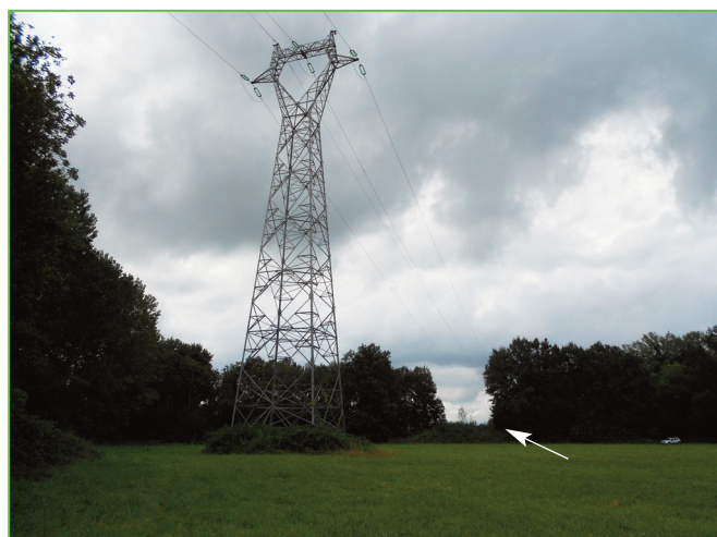
Portée 19-20 : franchissement du bois en tranchée
