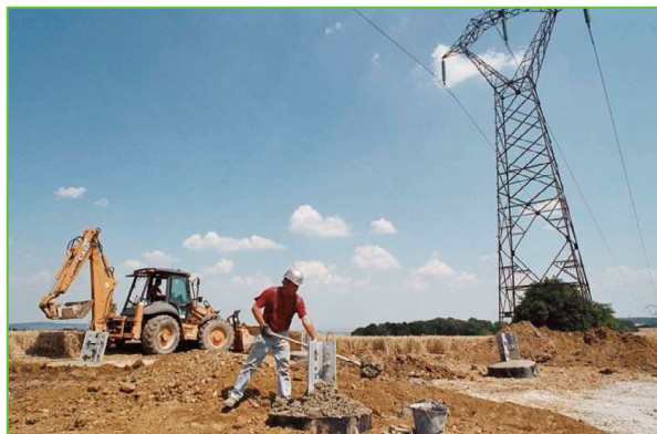
Réalisation de fondations : creusement, mise en place et bétonnage d'un massif de fondation, recouvrement
