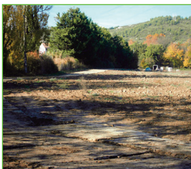
Exemple de plaques de protection des sols
