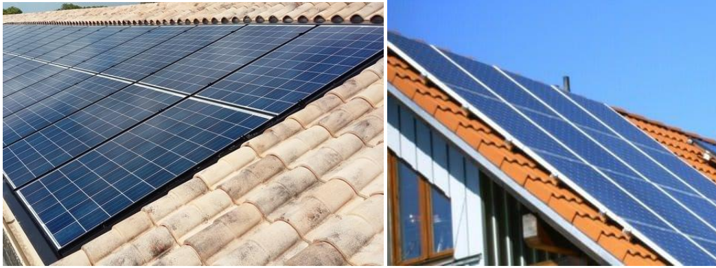
Exemple de panneaux solaires intégrés par rapport à la pente de la toiture
