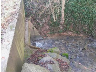
**Photo 3 et suivante : le pont à l'aval de la zone d'étude impose le niveau du cours d'eau et ne permet pas une bonne perméabilité sédimentaire, hydraulique et biologique.**
