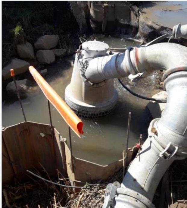
Figure 22 : Exemple de batardeau avec pompage
