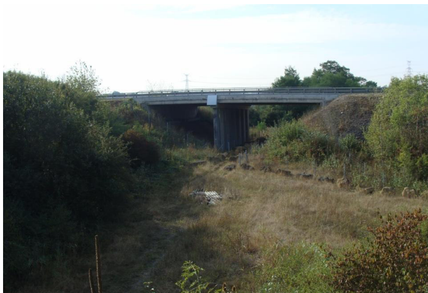
Passage inférieur sous l'A4
