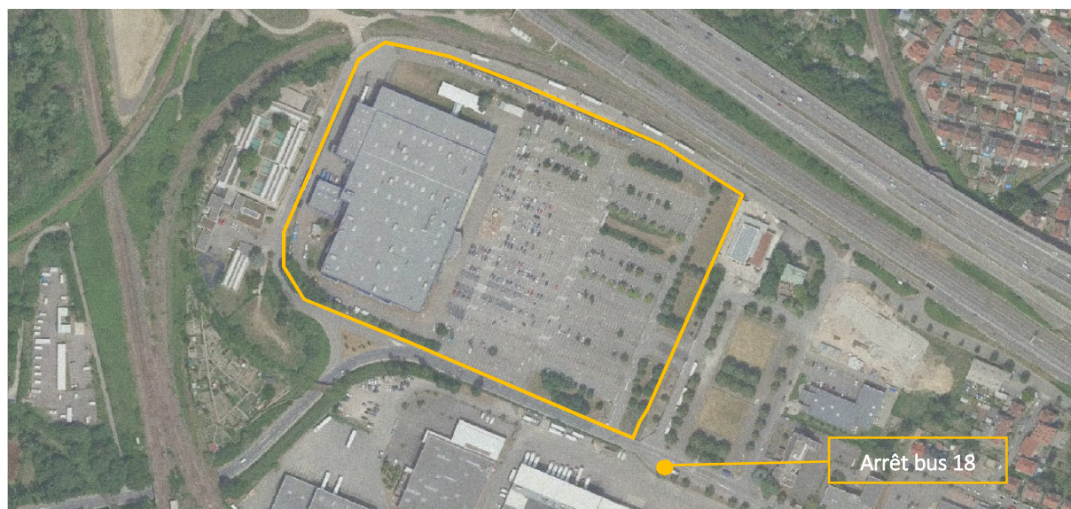
Vue aérienne du site IKEA de Strasbourg (Source. EMS)
