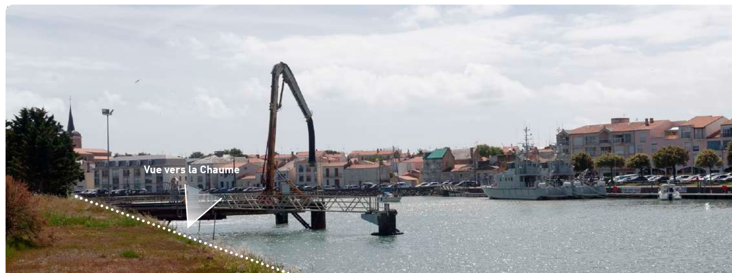
S1 - Un quai non accessible et non aménagé
