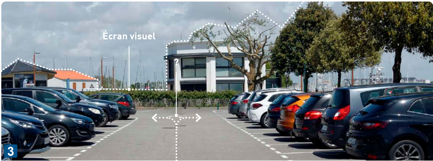
Des espaces de stationnement qui perturbe la lisibilité des entrées
