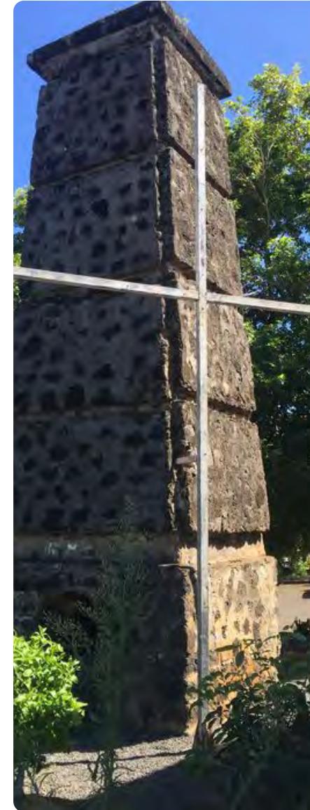
MH7 - Cheminée de Basse-Terre Source : ©Ministère de la Culture
