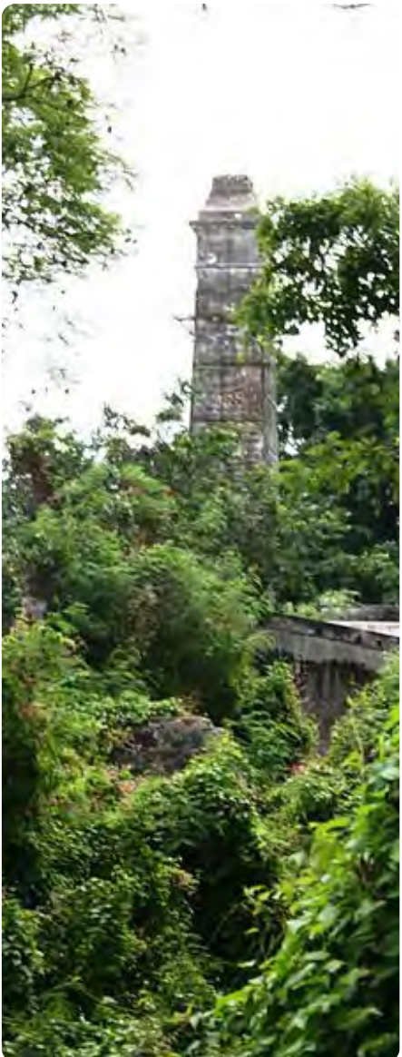
MH4 - Cheminée dite de la Vallée Source : ©Thierry Caro - Creative Commons
