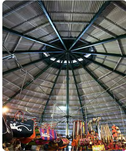
MH10 - Marché de Saint-Pierre Source : ©Thierry Caro - Creative Commons
