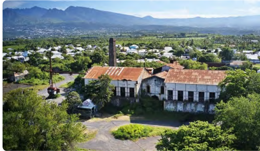
MH14 - Usine sucrière de Pierrefonds Source : ©Fondation du Patrimoine - Myphotoagency - Christian Bersano
