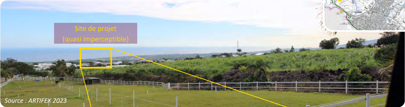
83 - Depuis le Chemin des Châtaigniers à 5,4 km au Nord-Est du site de projet
