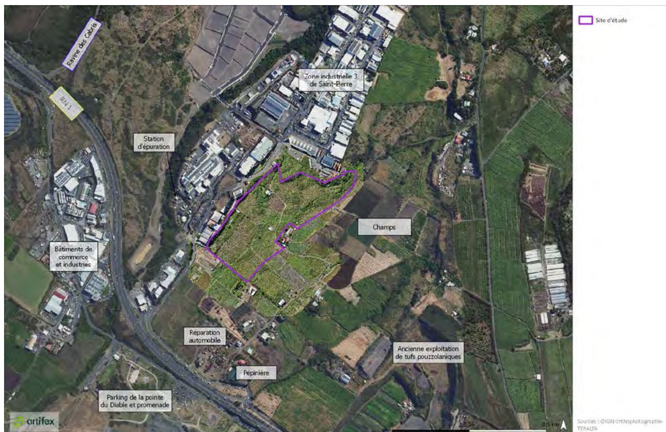
Illustration 2 : Vue aérienne du site et de son environnement Réalisation : ARTIFEX 2024
