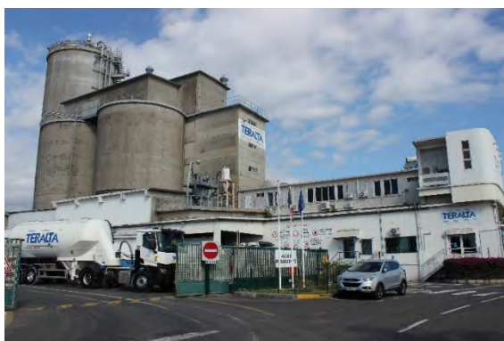
Terminal cimentier de TERALTA CIMENT REUNION au Port Source : ARTIFEX – Prise de vue du 19/07/2023
