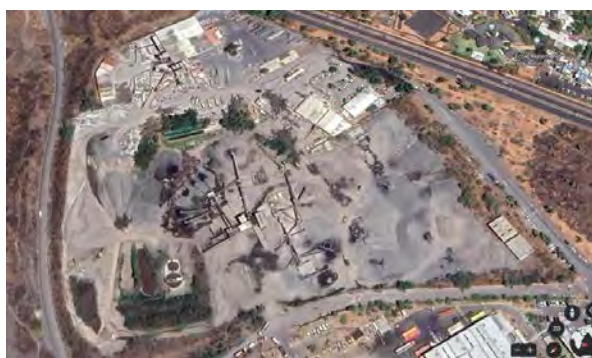
Installations de traitement de TGBR sur la commune du Port
