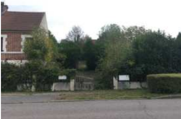
Vue de l'habitation à réhabiliter
