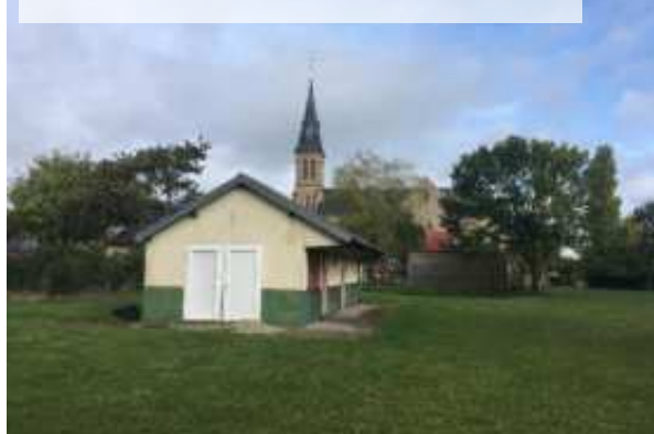
Vue des anciens sanitaires à démolir
