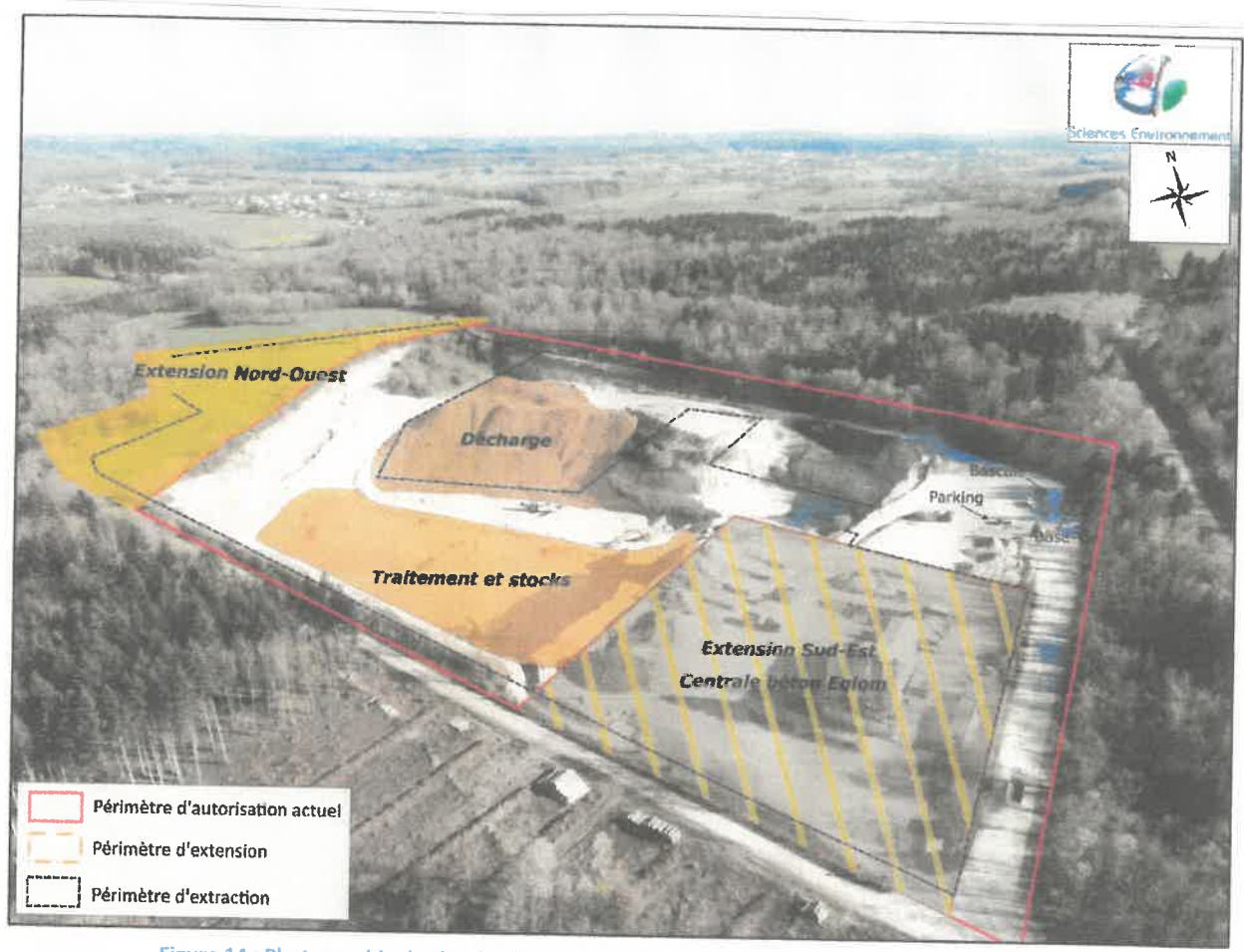
Figure 14 : Photographie du site de Chevigny-lès-Vercel dans son état actuel – avril 2024
