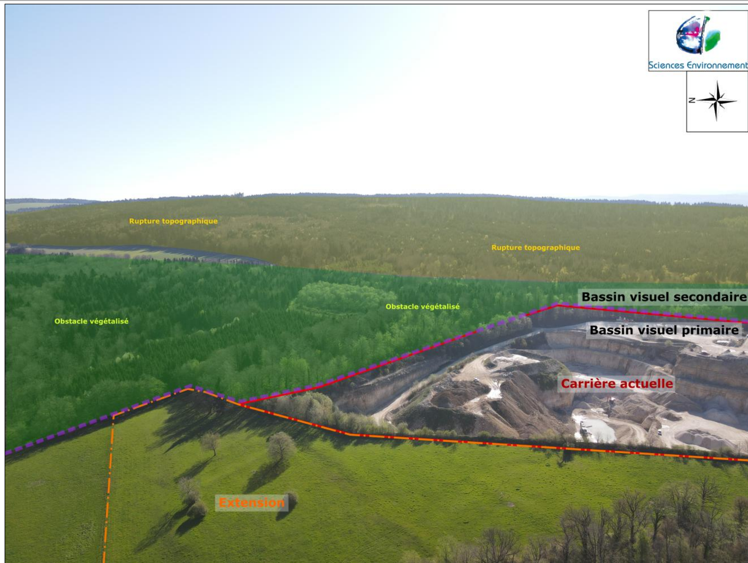
Figure 69 : Bassins visuels du site d'étude – Secteur Est
