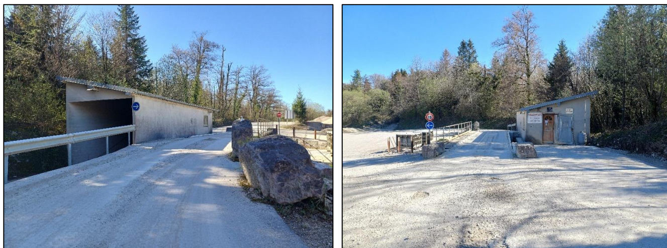
Figure 11 : Photographies de la base-vie de la carrière de Chevigny-lès-Vercel
