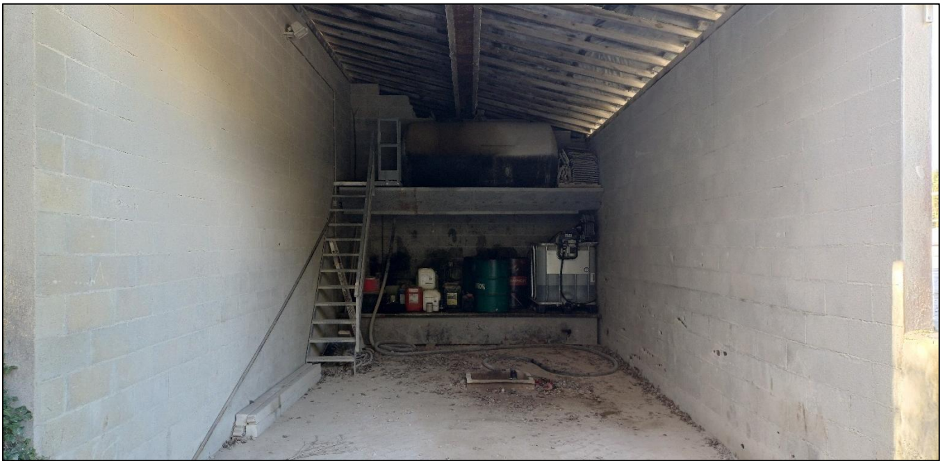
Figure 13 : Stockage sous aire étanche couverte des produits d'entretien
