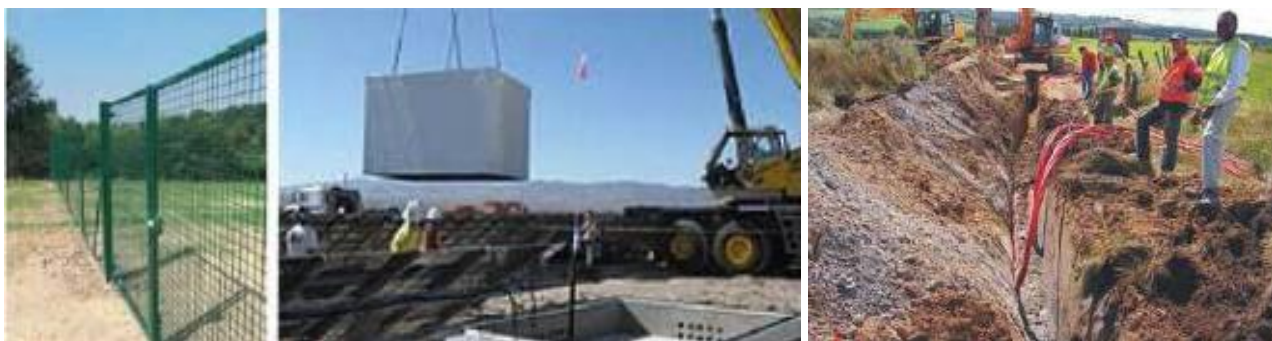
Illustration 33 : Exemple de chantier d'un parc photovoltaïque au sol
