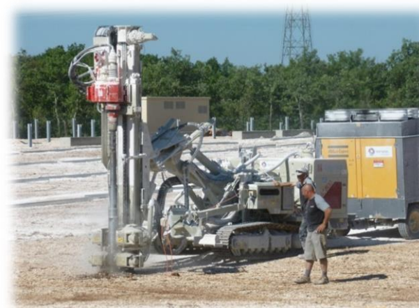
Illustration 6 - Ancrage au sol par pieux battus
