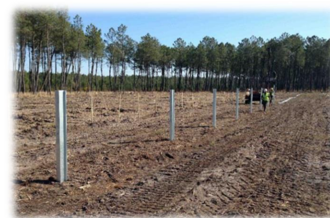
Illustration 6 - Ancrage au sol par pieux battus
