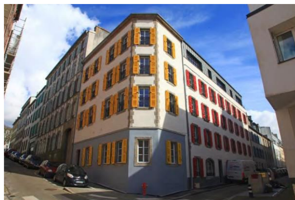
Figure 57 : Réhabilitation de logements à Recouvance (crédits : ADEUPa)
