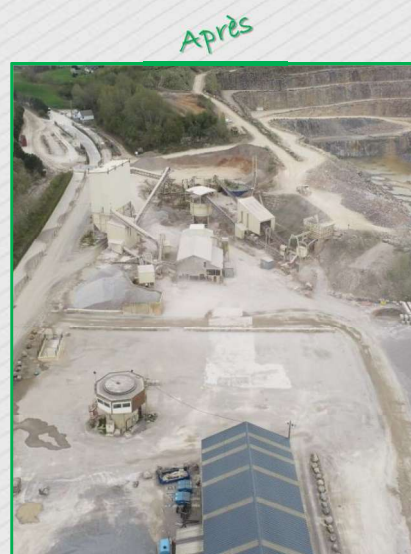
Démantèlement (suppression du risque et des non-conformités réglementaires).
