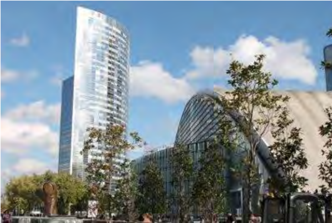
Tour Trinity – La Défense 75 000 tonnes de matériaux livrés
