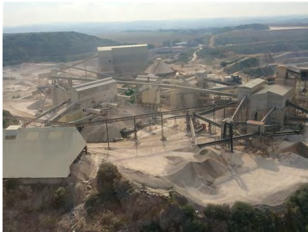
Carrières du Boulonnais, Installations et T2004
