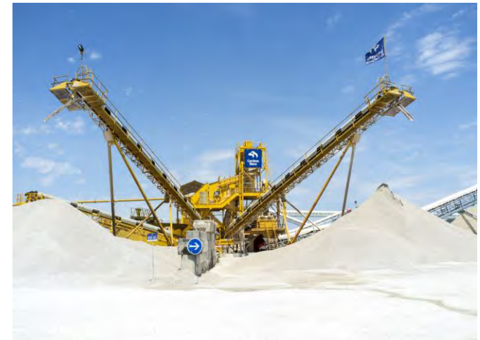
Carrières Blanc, installations
