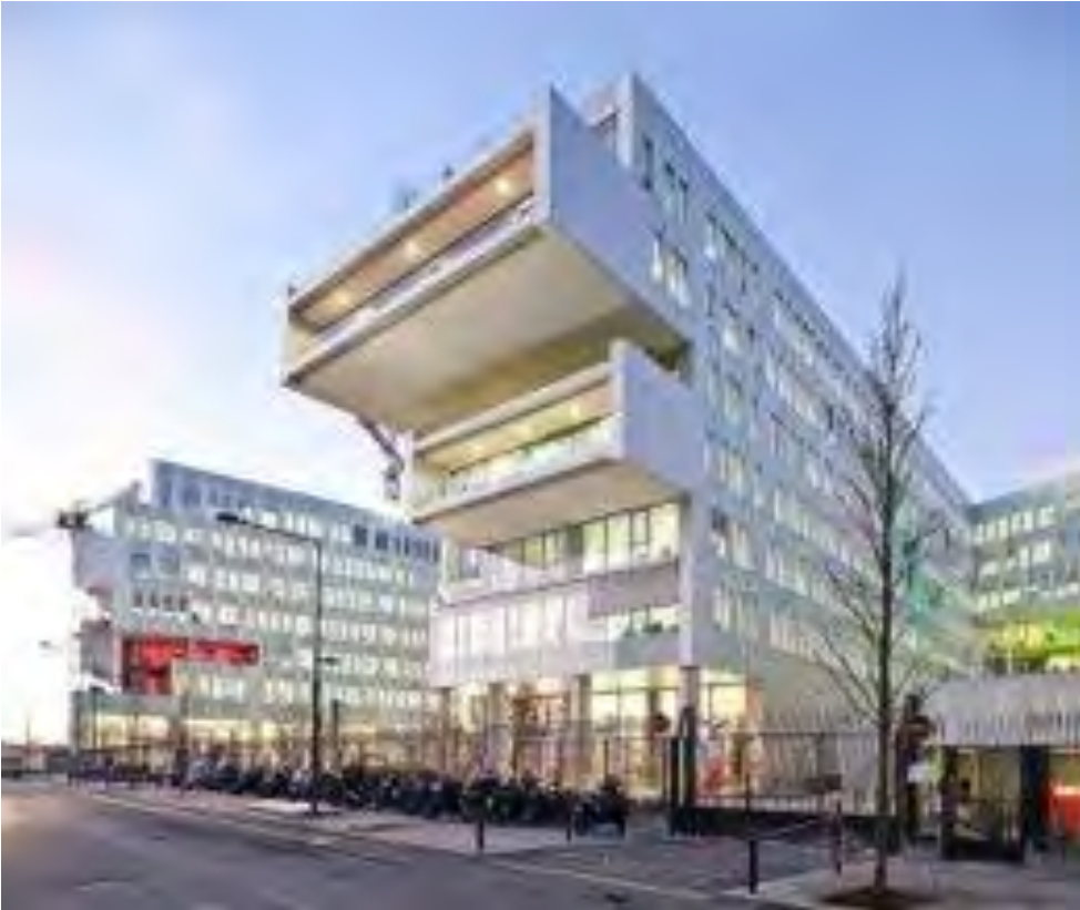
Campus SFR– St Denis 80 000 tonnes de matériaux livrés
