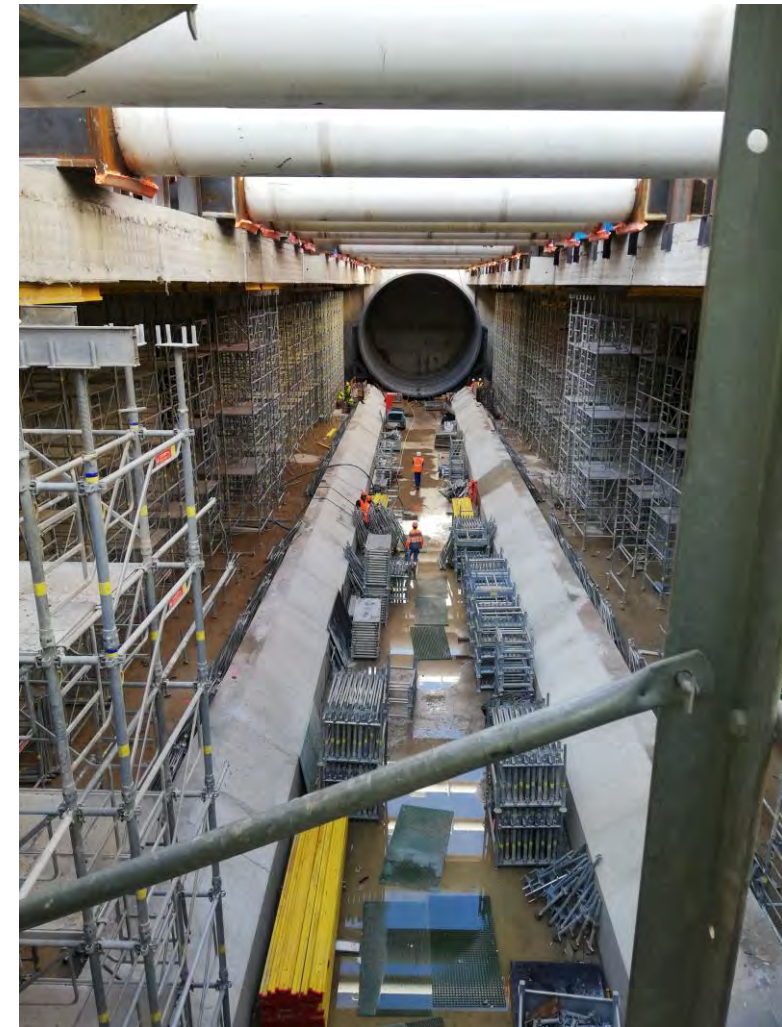
Lignes 14, 15 et 16 métro Paris et chantier Eole + d'1,5 million de tonnes de matériaux livrés.
