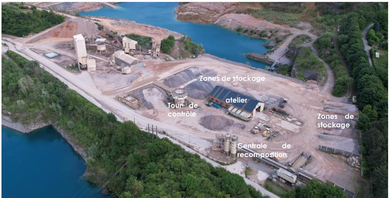
A l'est de la plate-forme se trouve un atelier de stockage des huiles et des pièces de rechange où peut être réalisé des opérations de maintenance. Une installation de reconstitution de gravas et un laboratoire complètent les installations.
