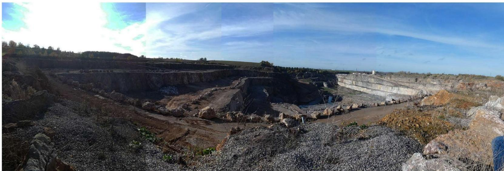
▶ Vue sur la carrière en cours d'extraction. A gauche la zone récemment décapée, de gauche à droite les fronts d'extraction Ouest, Nord et Est, à droite la piste
