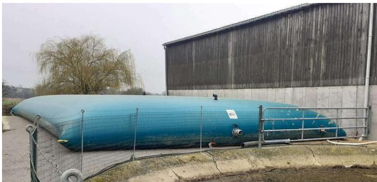
Figure 12 : Réserve incendie en exploitation agricole (Source : Citerpack)
