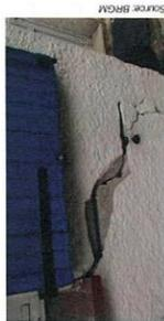
Le phénomène de retrait-gonflement se manifeste par des mouvements différentiels qui se concentrent à proximité des murs porteurs, tout particulièrement aux angles d'une construction. Il peut engendrer des dommages importants sur les bâtiments et même compromettre la solidité de l'ouvrage: fissures ou lézards des murs et cloisons, affaissement du dallage, ruptures de canalisation enterrée.
