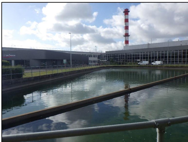
Bassin incendie (Source : ATLAM)
