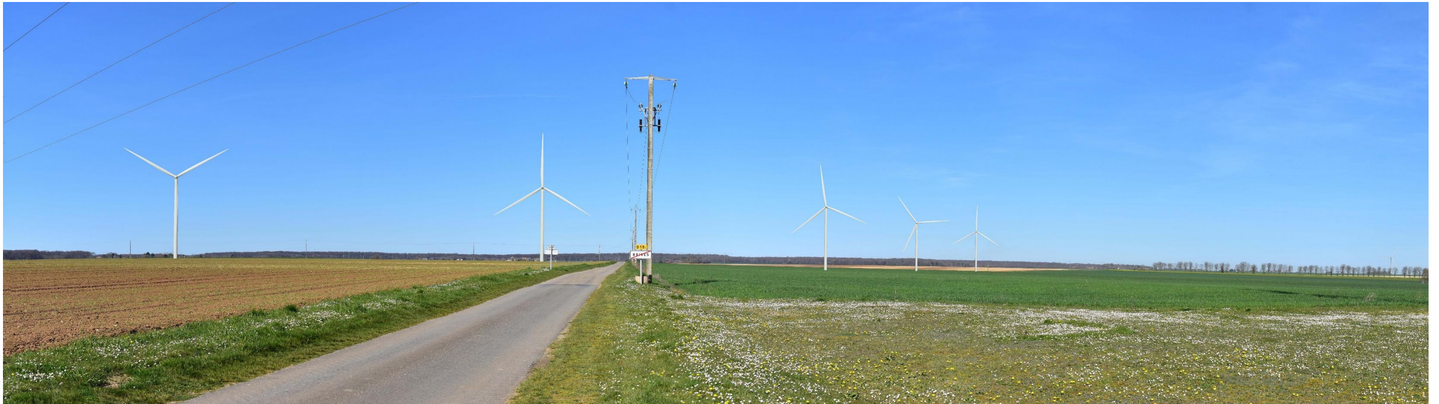
Photographie 6 : Vue depuis Brives au niveau de la route D19 (point de vue n°30)
