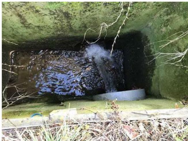
Figure 8- Exutoire du DO – vers le réseau pluvial puis vers le Ratier
