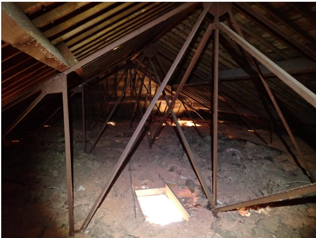
Figure 1 : cliché des combles - TBM environnement 2022
