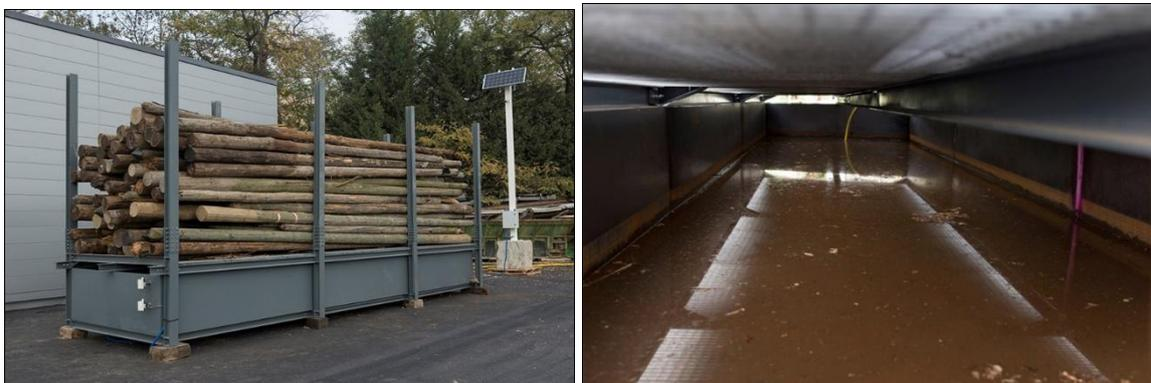
Figure 17 : Rack de stockage de bois C et sa rétention
