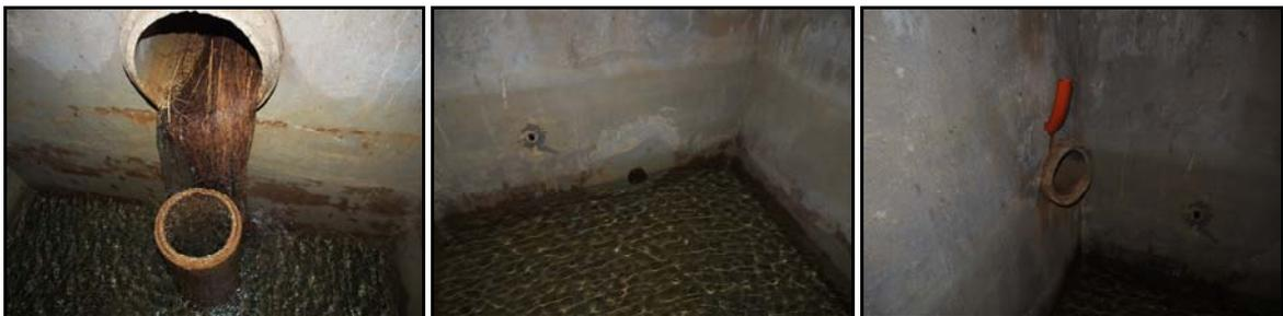
Figure 6 - Présentation des différents drains dans la chambre de réception des eaux (respectivement de gauche à droite, buse ciment 350mm de captage des eaux et buse ciment 200mm d'utilisation inconnue, drain d'adduction en fonte 100mm vers la station de pompage, et buse ciment 200mm pour le trop-plein)
