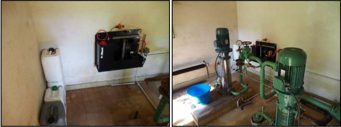
Figure 9 - Installation dans la station de pompage (traitement bactéricide à gauche et les 2 pompes à droite)
