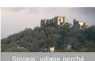
Soyans, village perché sur la pente, dominé par les ruines du château,
