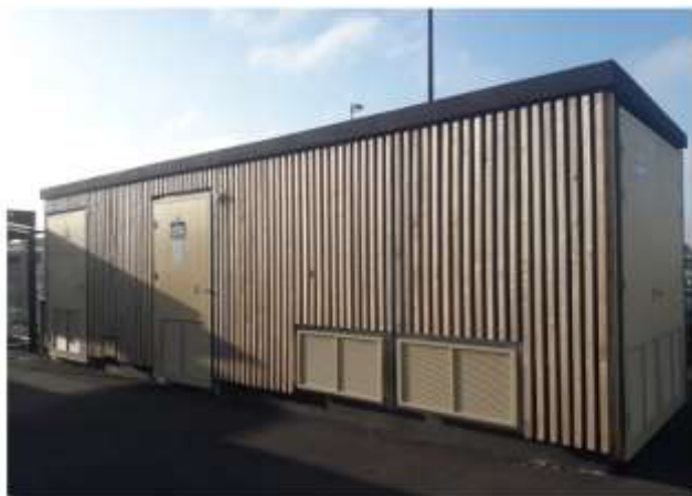
Figure 78 : Illustration d'un poste électrique avec habillage bois
