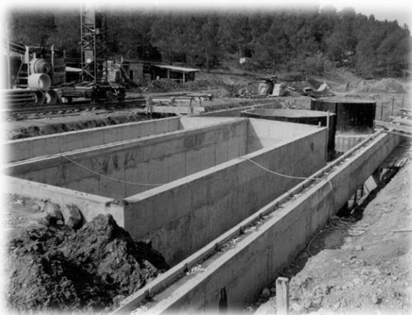
Figure 2 : Fosse F1, piscines P1 et P2 et longrines du portique 300 kN en construction
