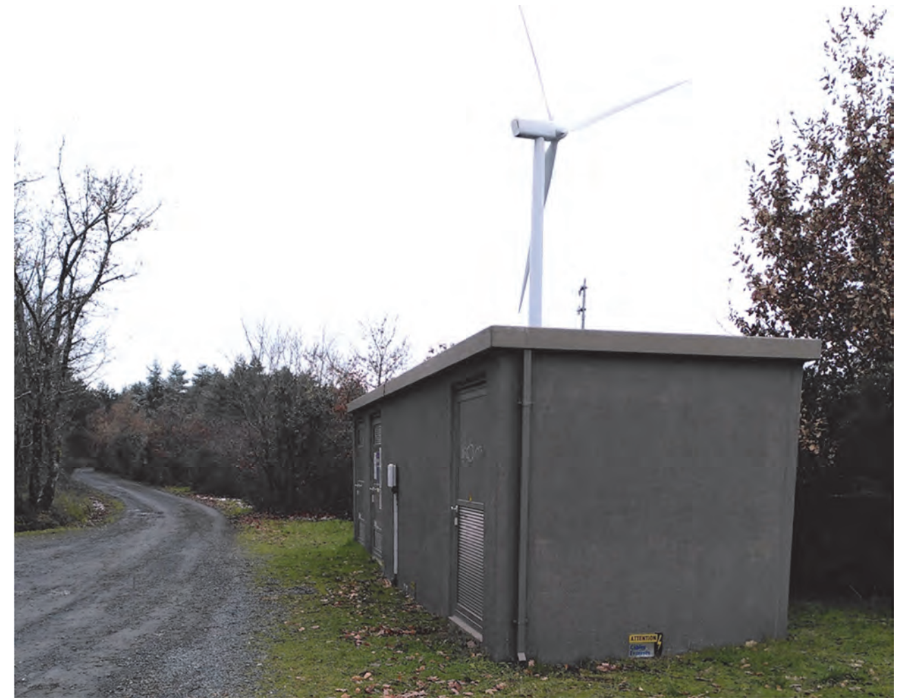
Illustration 34 : poste de livraison actuel du parc éolien de Cuq-Serviès (Source ABO Energy)
