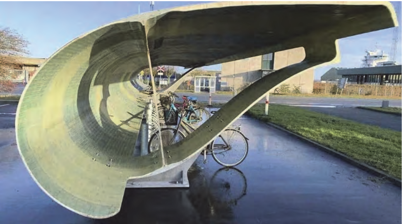
Illustration 46 : exemple d’abri pour vélos avec réutilisation d’une pale d’éolienne (source : https://www.santafixie.fr/blogfr/wp-content/uploads/2021/10/pala-generator-eolico-reciclada2.jpg )
