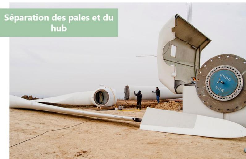
Photographie 4 : Séparation des pales et du hub (Source : ABO Energy)
