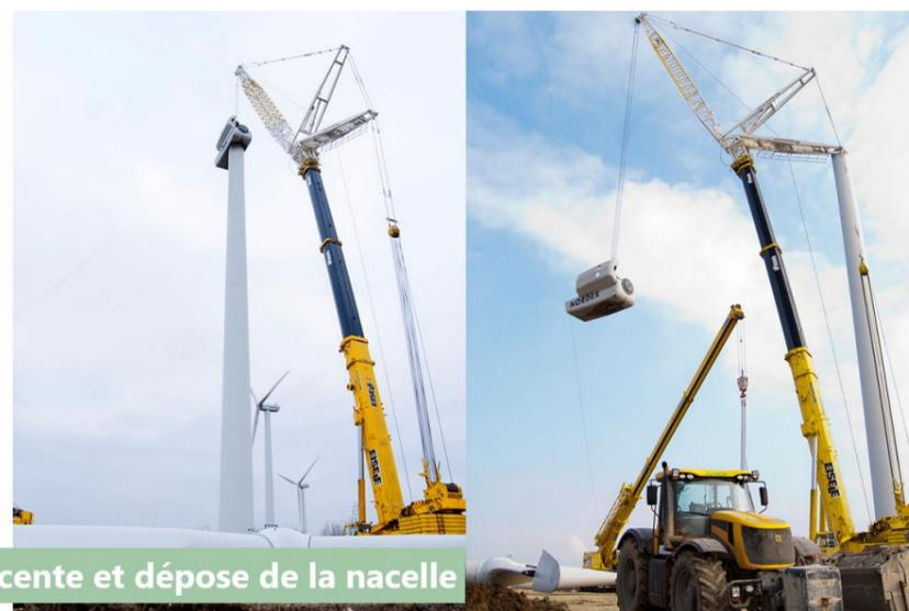
Photographie 3 : Descente et dépose de la nacelle (Source : ABO Energy)
