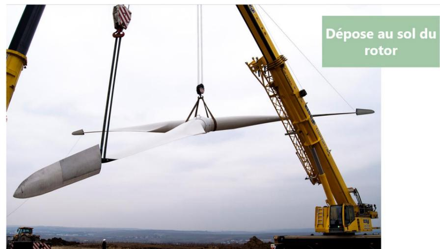
Photographie 2 : Dépose au sol du rotor (Source : ABO Energy)
